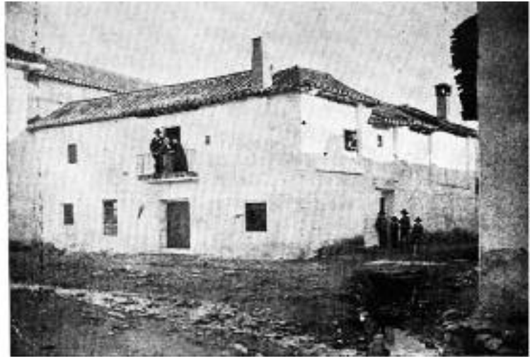
Huétor Vega el 25-XII-1893 a las 2 de la tarde. Casa de D. Emilio Pérez-Rejón Bueno que aparece en el balcón con su esposa. Esquina calle Real y carretera hacia Monachil.
